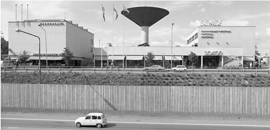
Infrastrukturbyggandet är en viktig del av den byggda miljön – exempel från Karhula. Teuvo Kanerva/Museiverket
