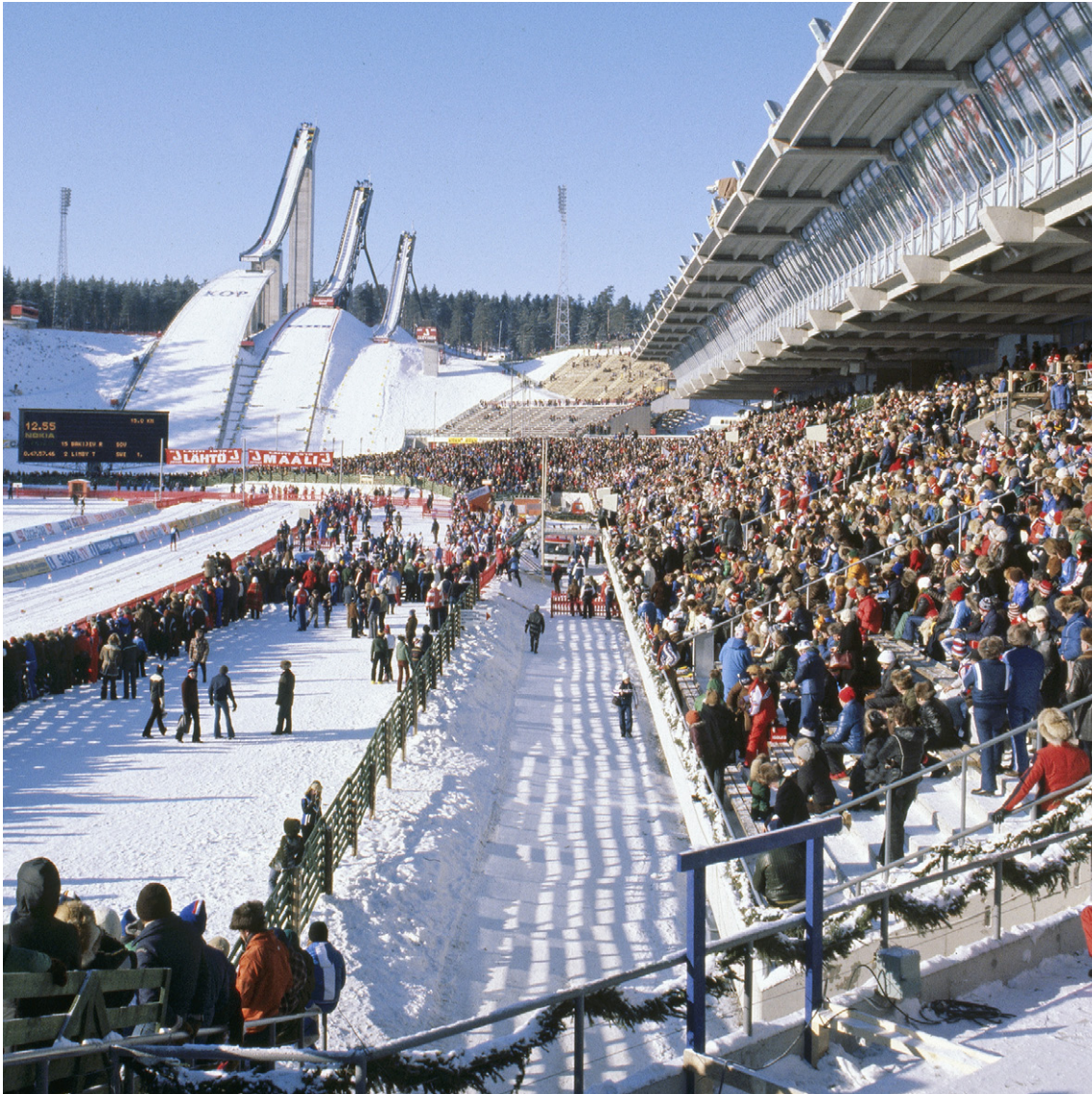
Betongstrukturerna i Salpausselkä idrottscenter ger objektet en ikonisk karaktär. Teuvo Kanerva/Museiverket
